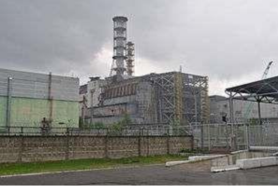
Figura 2.6. Vista de la central nuclear de Chernóbil, donde se puede observar el "sarcófago" construido sobre el reactor averiado.
