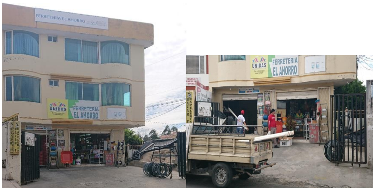
Fotografía 1 Fachada Ferreteria El Ahorro
