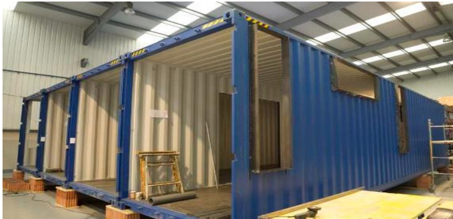
Gráfico 23. Cortes de ventanas e instalación de marcos metálicos en ventanas
